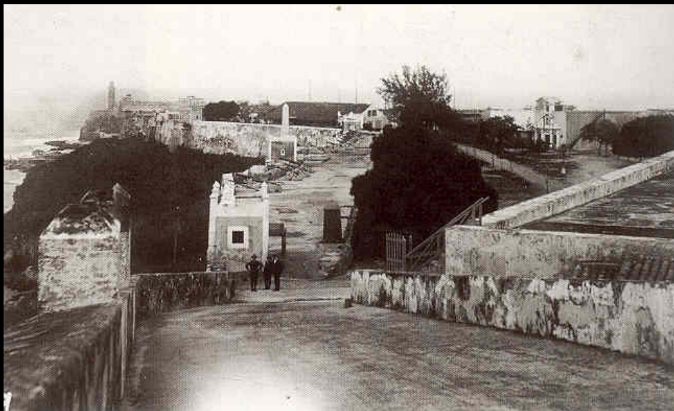
Rampas de la Fortaleza.
