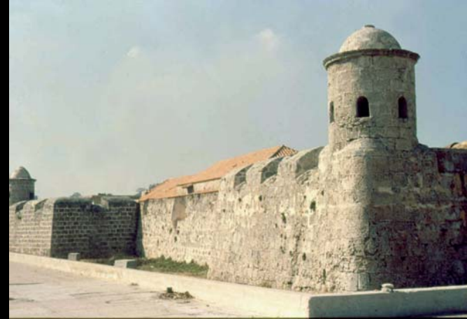
Aspecto del Castillo antes de la restauración.
