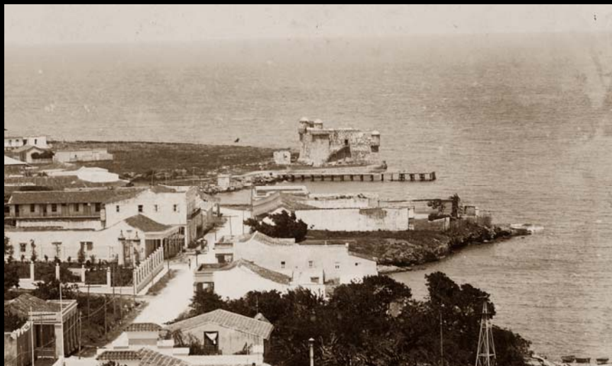
Vista del emplazamiento.
